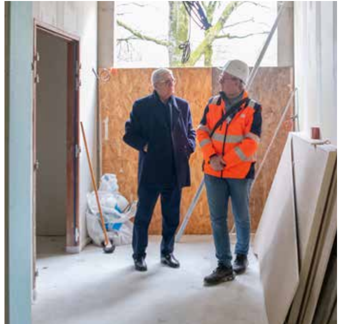
Mercredi 26 février, le maire lors d'une visite du chantier de l'école élémentaire Jean-Montalat en cours de restructuration - un autre espace dédié à la culture et à l'apprentissage. L'objectif est là encore de créer un cadre agréable et porteur, tant pour les enfants que pour tous les professionnels qui les accompagnent.
