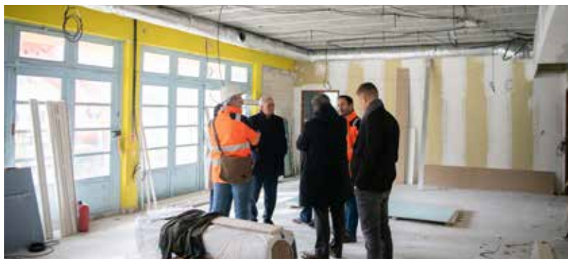
Le Maire a fait une visite de chantier, fin février, pour constater l'avancée des travaux.
