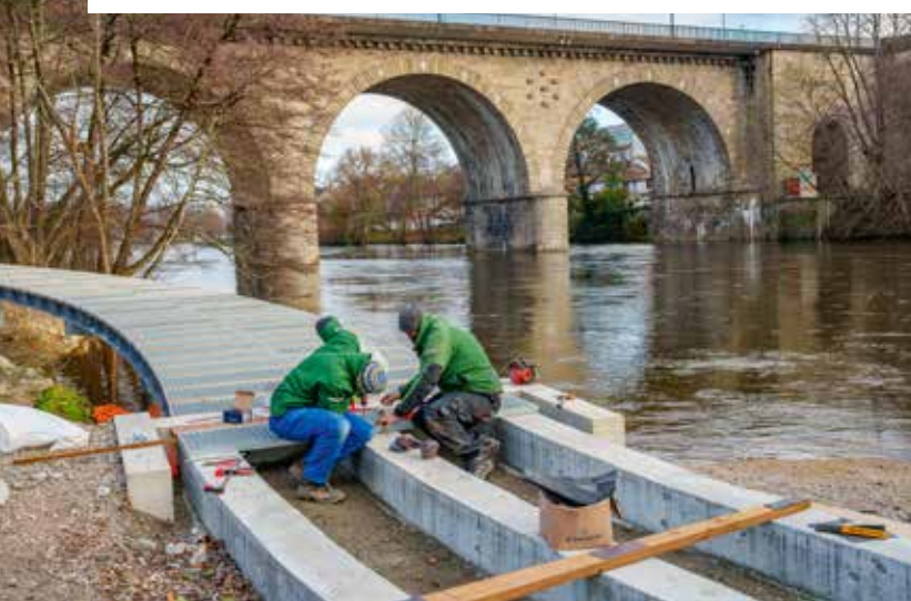
La passerelle de l'Anjoumard en cours d'assemblage.
