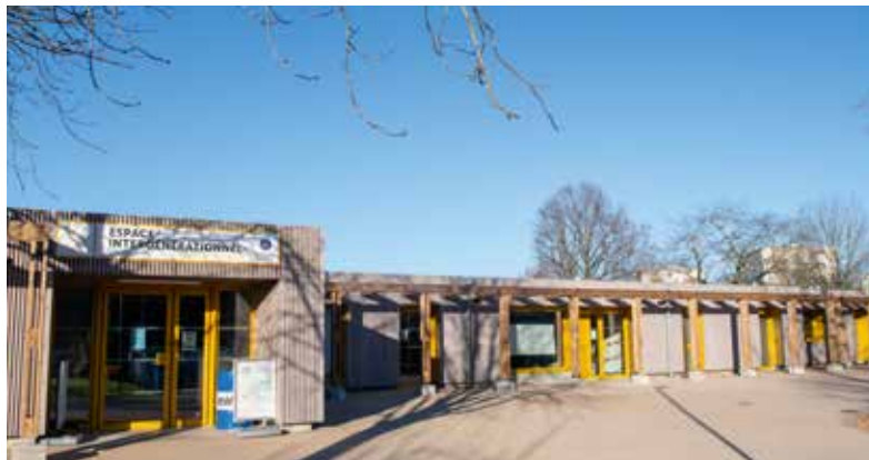
Intégralement réhabilité par la Ville, l'espace intergénérationnel Robert-Hébras a ouvert ses portes à la rentrée de septembre 2024.
