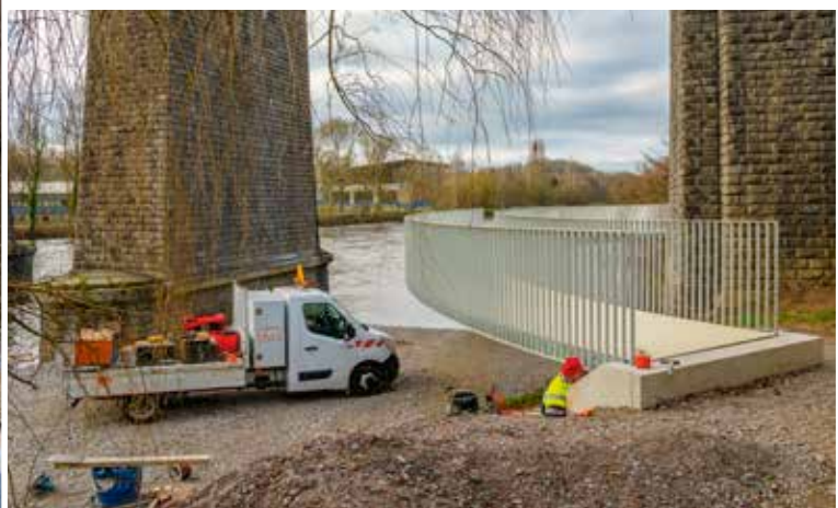
La passerelle autour du Viaduc SNCF permet de poursuivre son chemin en bord de Vienne sans avoir besoin de remonter sur le boulevard comme avant.
