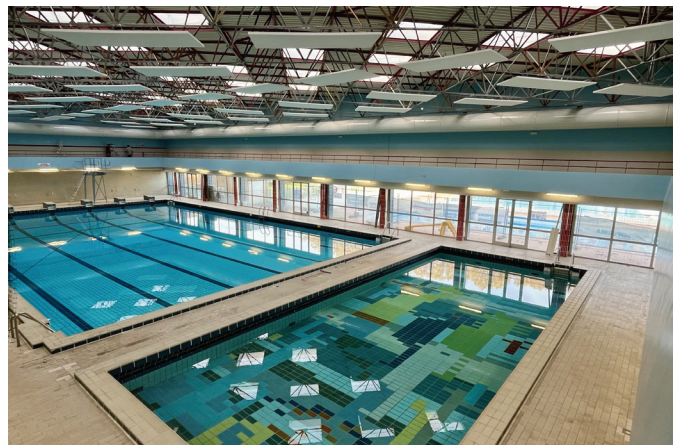
Les travaux de finition sont en cours au bassin d'hiver.
