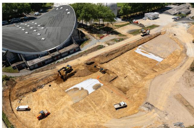
**Le terrassement pour construire ces deux annexes est achevé et les réseaux ont été déviés :** eaux pluviales avec la création également d'un bassin de rétention, potables et usées, réseaux électriques (y compris haute-tension), gaz, réseau de chauffage urbain, fibre et courant faible... **Les travaux de fondations débutent ce 1<sup>er</sup> juillet.**
