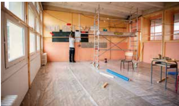
Les travaux à l'intérieur de l'école sont en cours : éclairage, peinture, faux plafonds, ... De nombreuses choses sont à refaire suite aux intempéries de septembre 2023.
